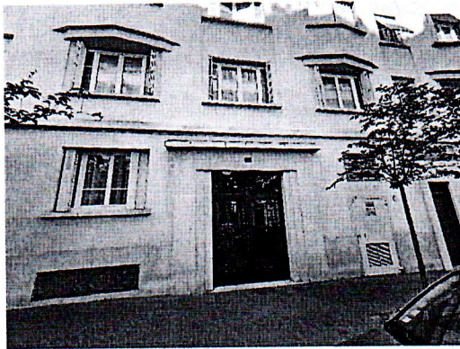
Façade rue Arthur Auger :
